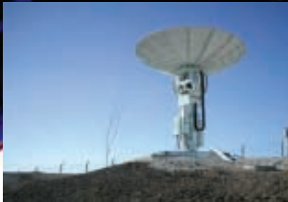
5.4m İKONOS UYDUSU TAKİP ANTENİ - İNTA SPACETURK YER İSTASYONU
