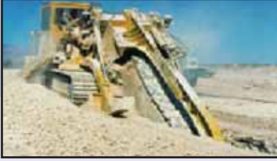
KANAL KAZI VE KABLO SERME ESNASINDA
