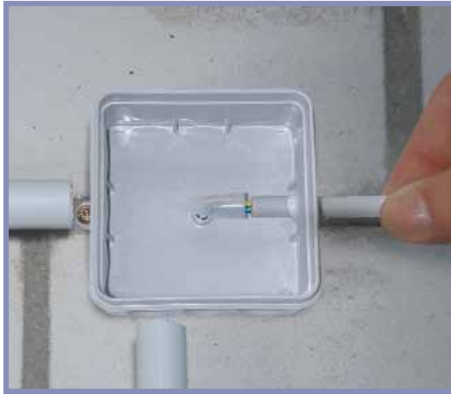
Birlikte teslim edilen delme zımbası hızlı ve kolay bir montaj sağlar
