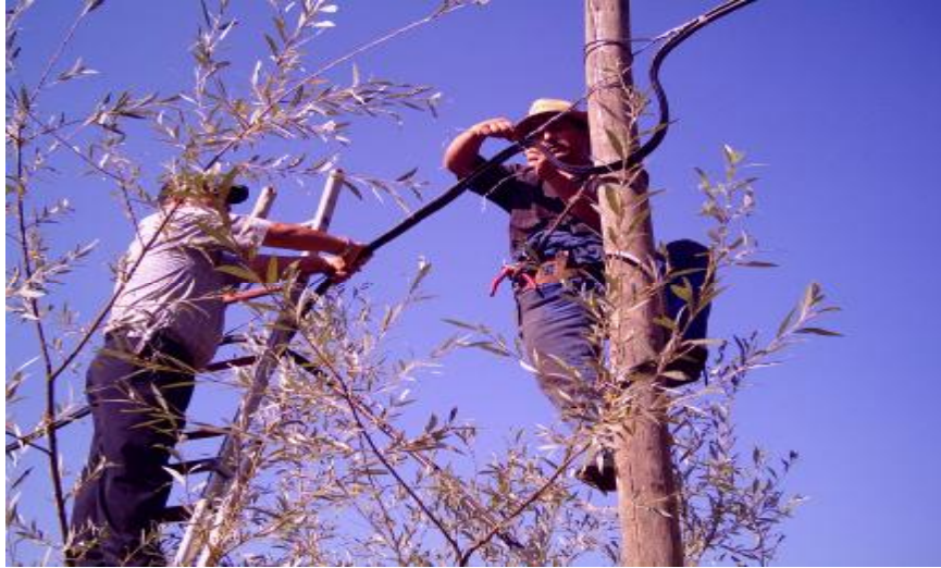
Resim 3.2: Yeni kablonun hatta baęlanması
