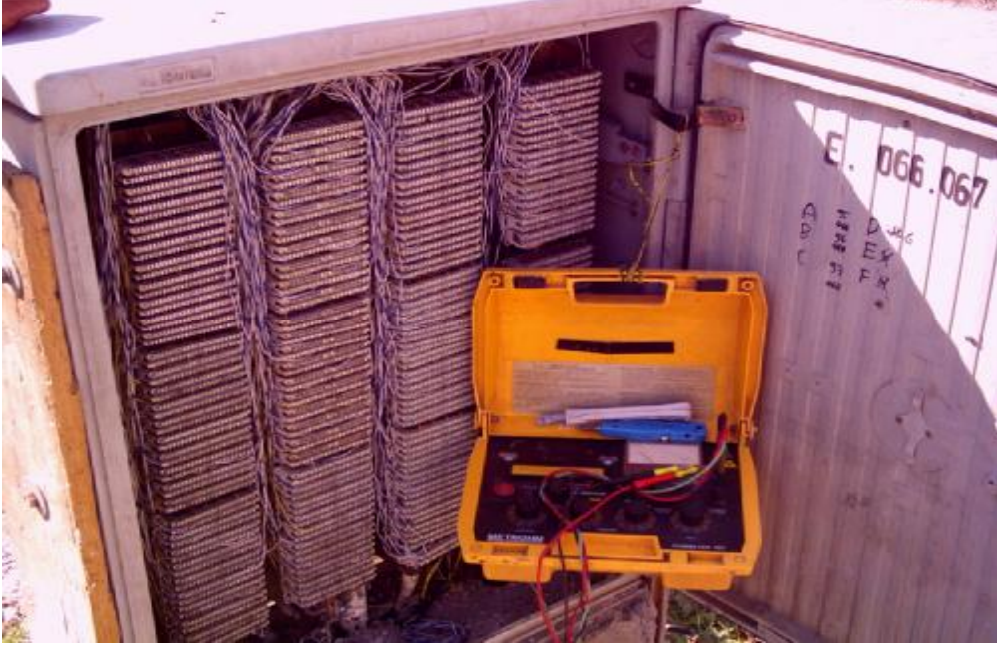
Resim 3.7: 18 C/2 ölçü aleti ile Saha dolabından arıza tespiti
