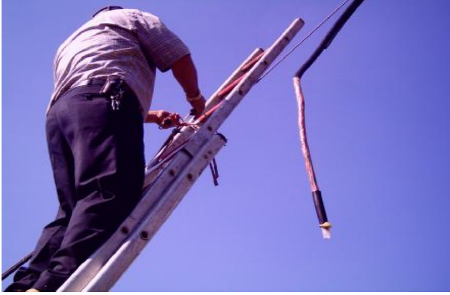
Resim 3.3: Yeni kablonun ek için hazırlanması
