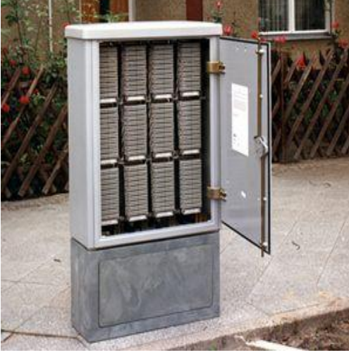
Resim 1.2: Saha dolabının içten görünümü
