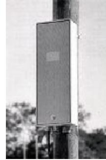
Resim 4.4: Direk tipi saha dolabı
