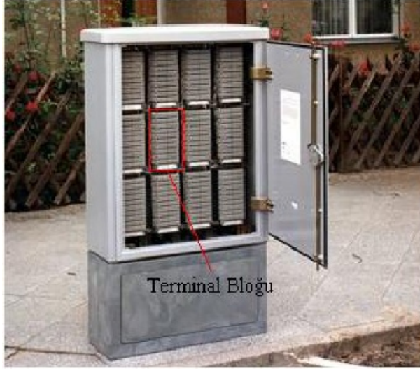
Resim 4.1: Saha dolabı terminal bloęu
