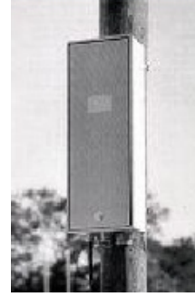
Resim 4.11: Direk tipi saha dolabı
