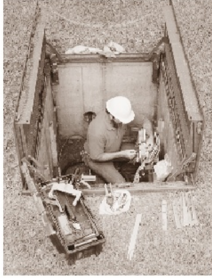
Resim 4.48: 300 per ve üzeri kabloların 25 perlik gruplar halinde modül bağlantısının yapılması
