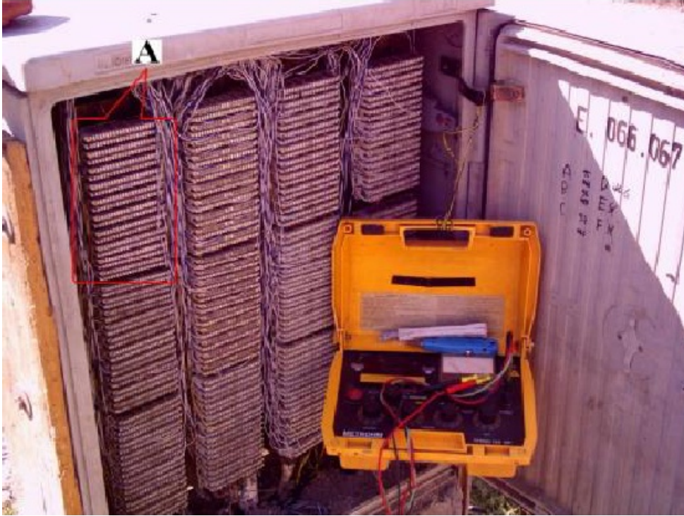
Resim 4.7: 1200'lük saha dolabının görüntüsü
