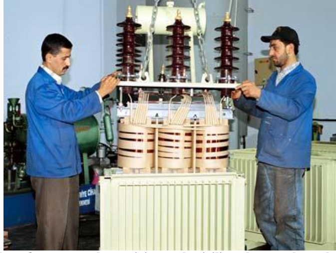
Resim 2.8: Transformatörün kazan içine yerleştirilip çalışmaya hazır hale getirilmesi
