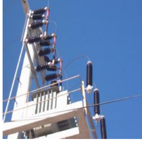
Resim 3.3: Ayırıcı bağlantıları yapımı
