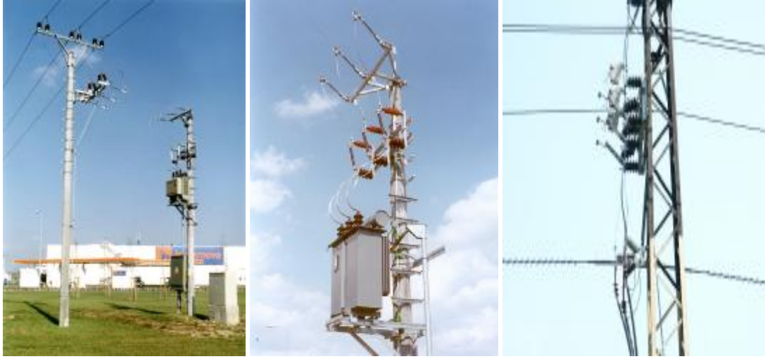
Resim 3.6: Ayrıcı bağlantıları
