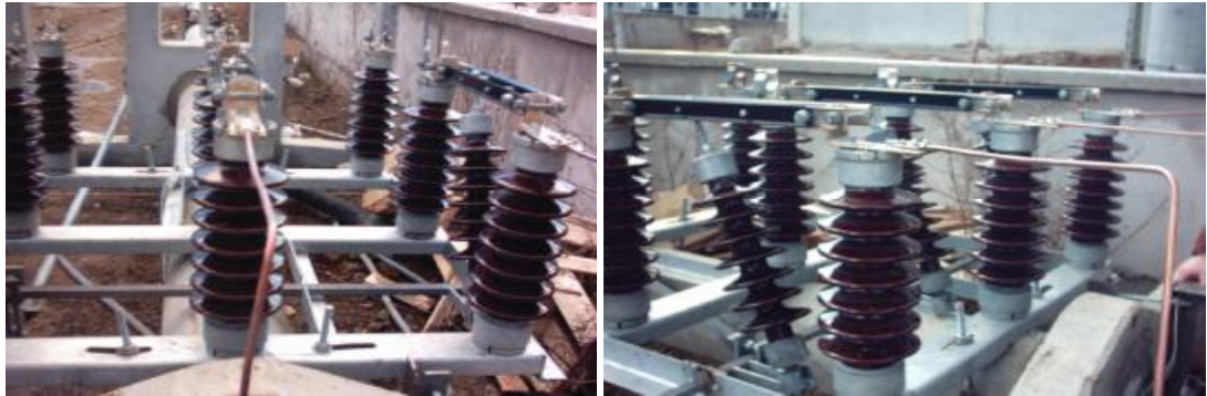
Resim 3.2: Ayırıcı bağlantıları
