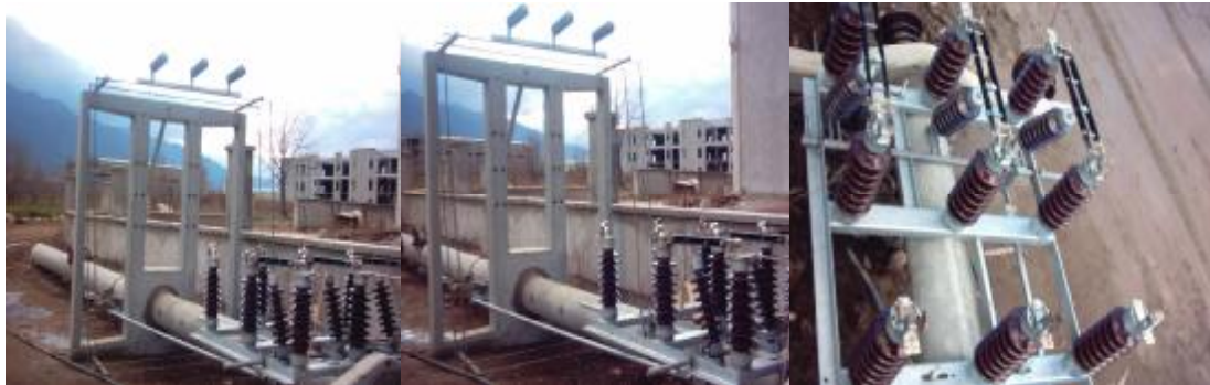
Resim 2.7: Yerde bulunan direğe ayırıcı montajı
