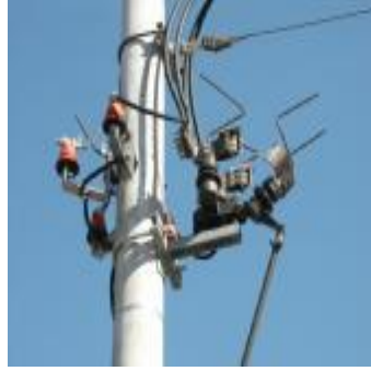
Resim 3.4: Ayırıcıların bağlantıları
