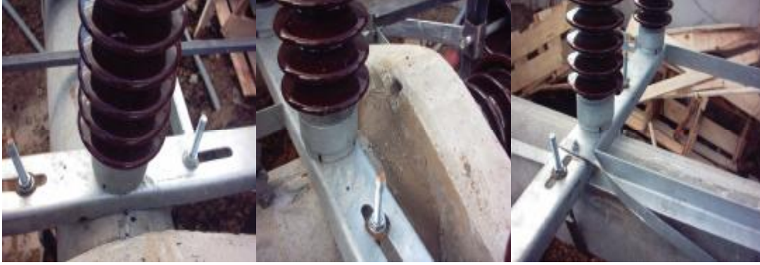
Resim 2.1: Ayırıcının beton direğe tutturulması
