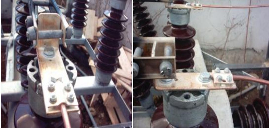
Resim 3.1: Harici sigortalı tip ayırıcı bağlantısı
