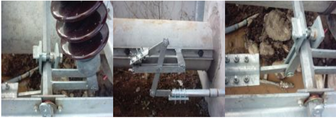
Resim 2.2: Ayırıcı kumanda mekanizmasının montajı
