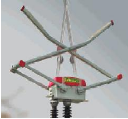
Resim 1.9: Ortadan açmalı ayırıcılar
