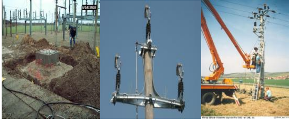
Resim 2.6: Şalt sahası ve direğe ayırıcı montajı
