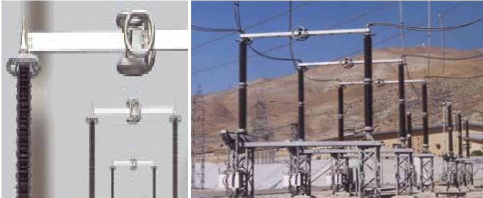
Resim 1.8: Ortadan açmalı ayırıcılar
