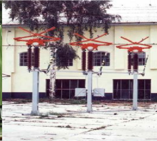
Resim 1.11: Pantograf ayırıcılar
