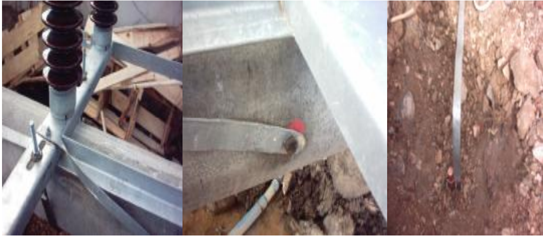
Resim 2.9: Ayırıcı topraklama şeritinin bağlantısı
