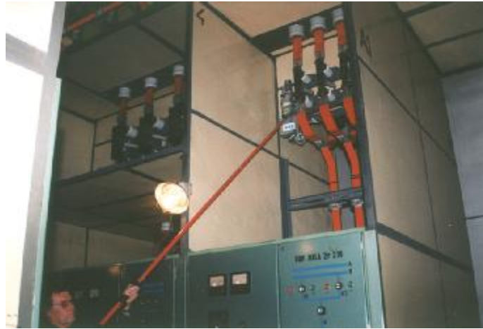
Resim 1.14: Elle kumandalı (ıstankalı) ayırıcı
