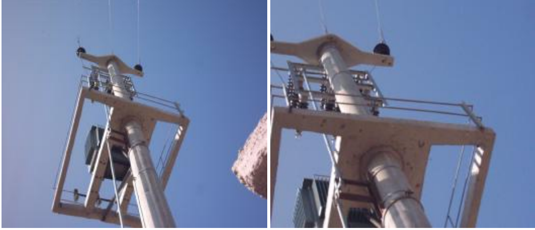
Resim 1.15: Mekanik kumandalı ayırıcılar
