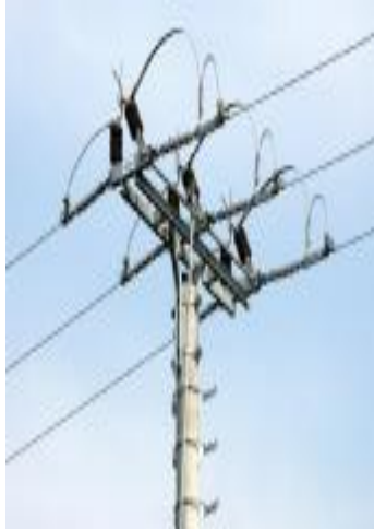
Resim 3.5: Ayırıcı bağlantıları
