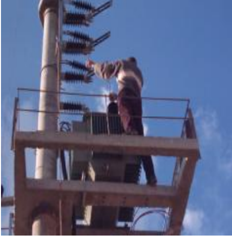
Resim 3.3: Ayırıcı bağlantıları yapımı
