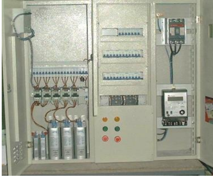
Resim 1.12: Orta büyüklükteki bir tesisin alıcılarının kompanze edildiği merkezi kompanzasyon panosu
