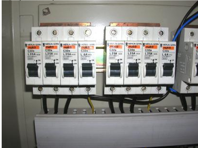
Resim 1.5: Kompanzasyonda kullanılan sigortalar
