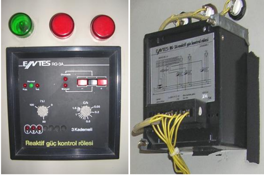
Resim 2.4.: 3 kademeli bir reaktif güç rölesinin önden ve arkadan görünüşü
